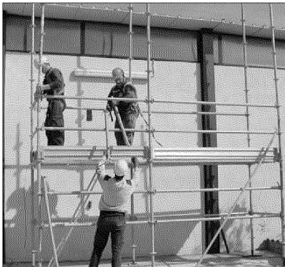
Un cantiere edile
