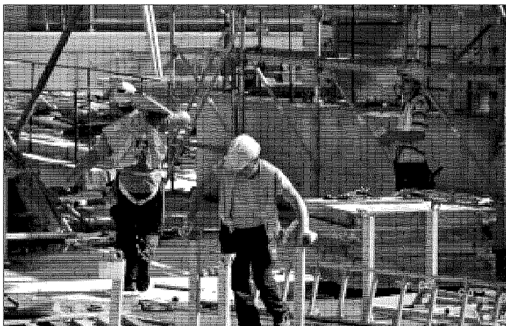
Operai edili al lavoro
