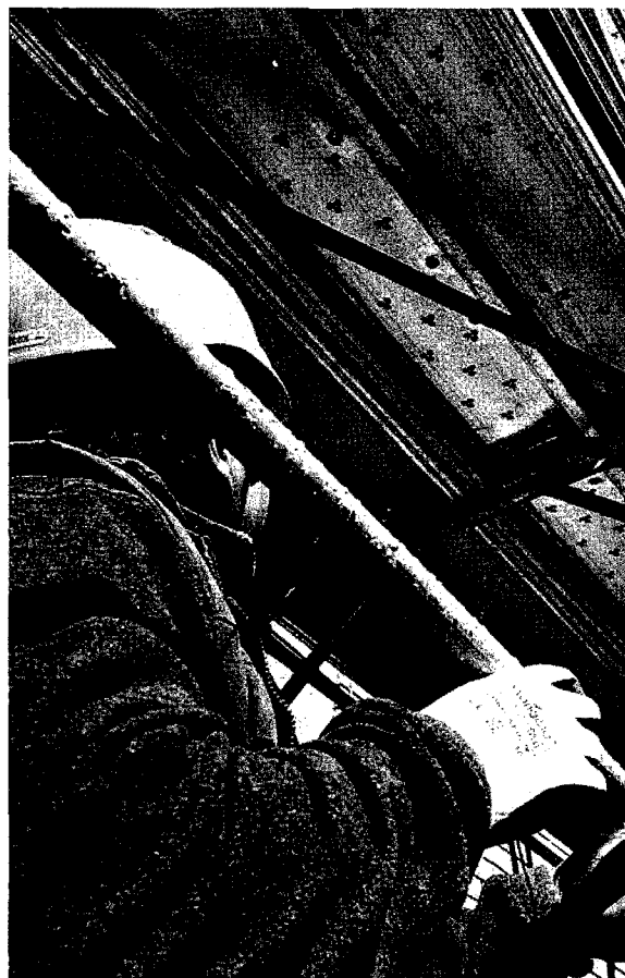
Edilizia Il settore è in crisi, a rischio 22mila posti di lavoro
