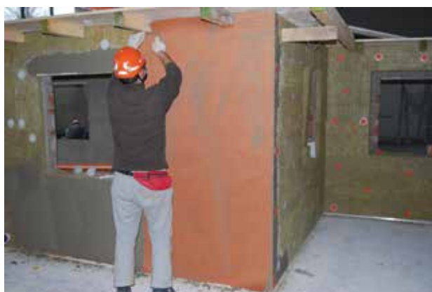
Fig. 9-10-11 Fasi di lavoro nei cantieri della scuola edile di Brescia Fonti foto: scuola edile Brescia
