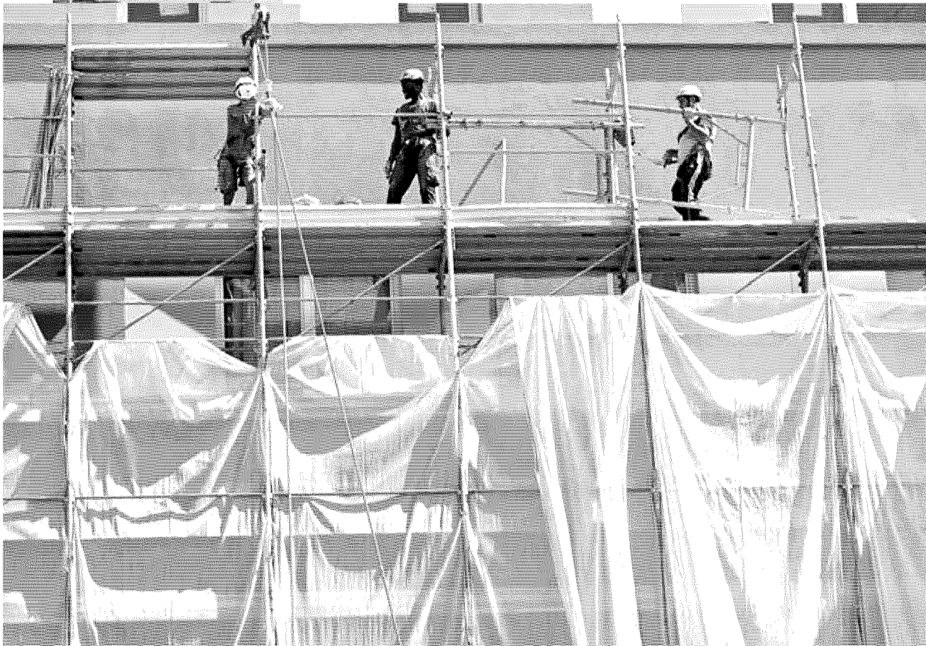
Operai edili al lavoro sulla facciata di uno stabile di Milano foto Ansa
