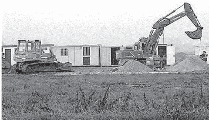
Ruspa al lavoro all'interno di un cantiere
