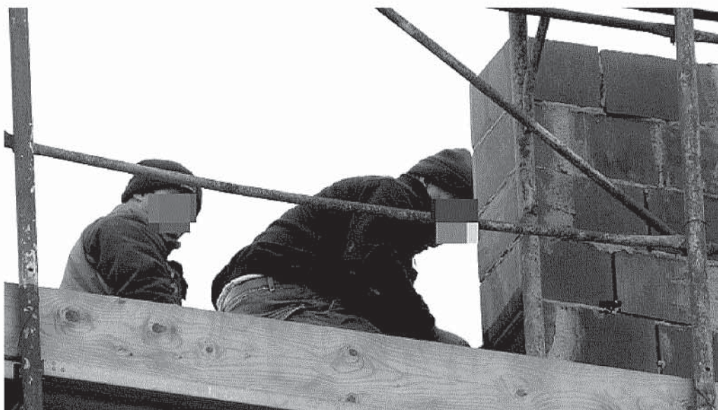
Due muratori in un cantiere: al lavoro senza gli accorgimenti per la loro sicurezza (foto Batavia)
