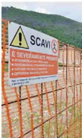
I cantieri dell'Arcisate-Stabio
