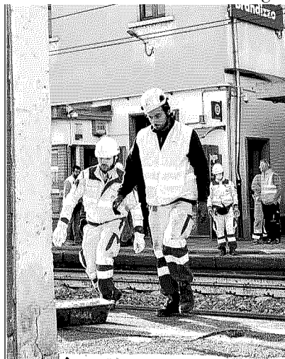
▲ In stazione Operai al lavoro sui binari della stazione di Brandizzo
