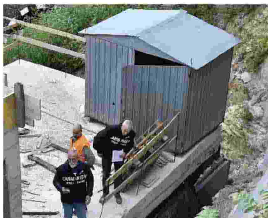
Il container nel cantiere di Moltrasio, nel Comasco, dove sono deceduti i due egiziani
