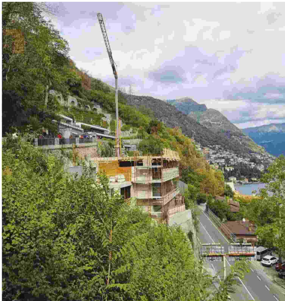
Moltrasio, il cantiere dove sono morti i due operai
